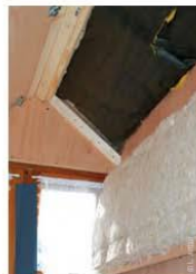
Construction d'un caisson isolé
