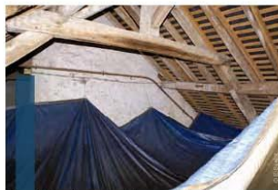
Bâches de protection dans un comble
