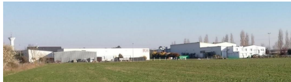
La ZA des Moncellières dans sa façade sud, donnant sur le chemin des Porteaux. La nouvelle desserte pourrait être aménagée entre les deux bâtiments.
