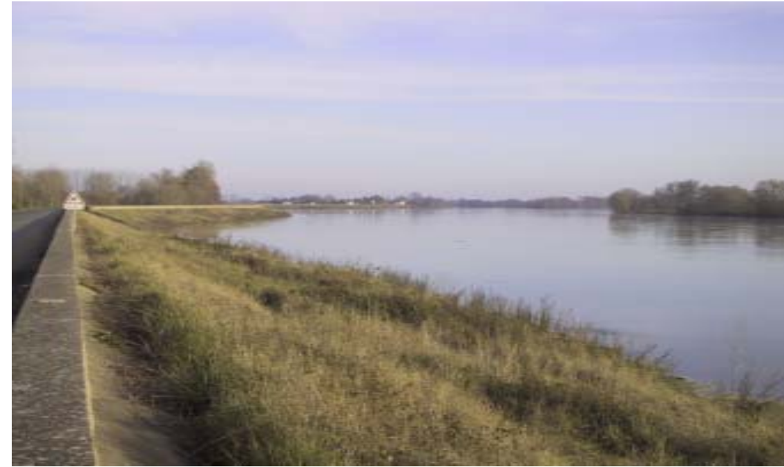
La levée de St-Georges en amont du pont de Montjean (photo DDE)
